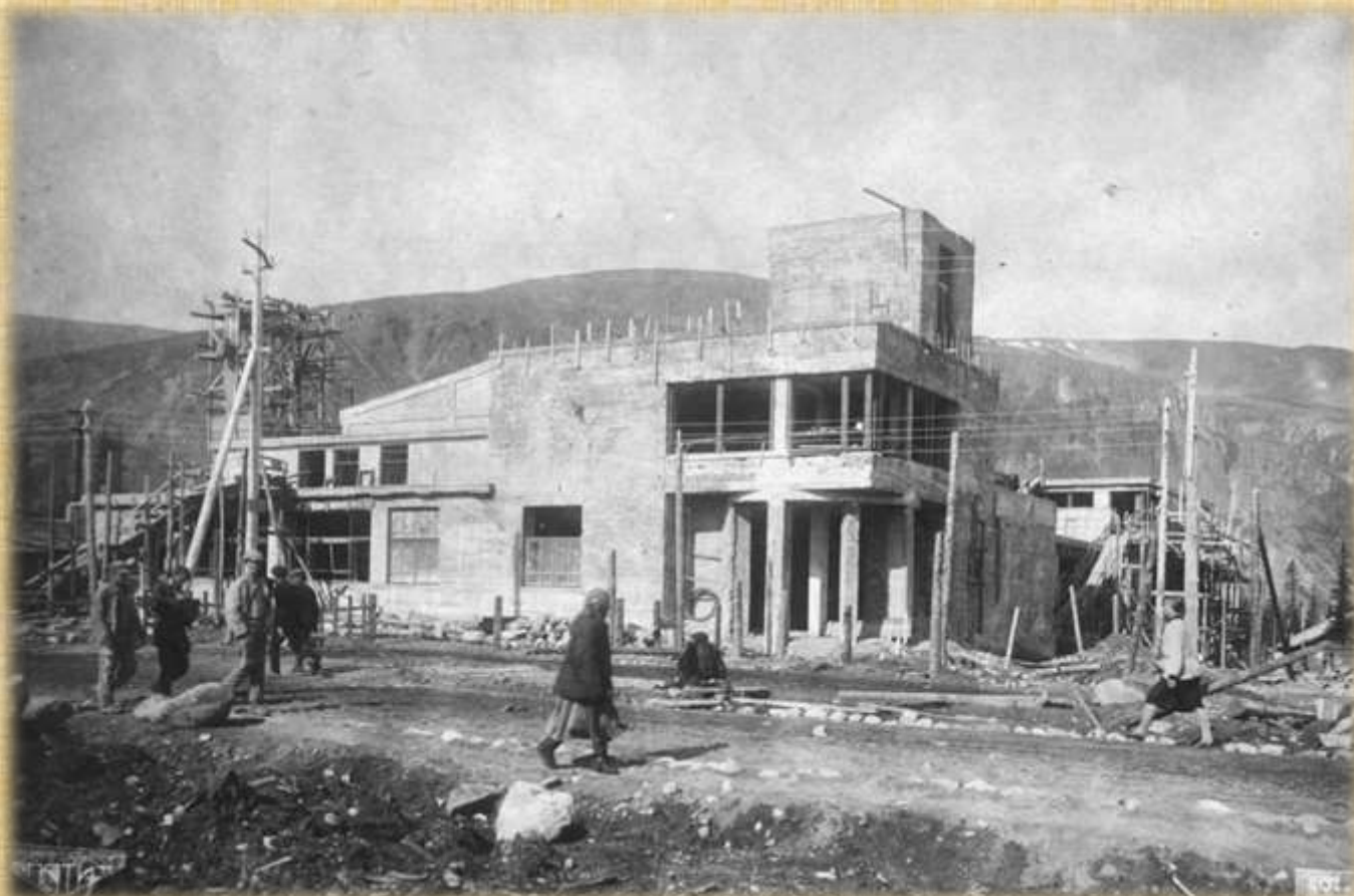
Строительство кинотеатра в городе Хибиногорске. 1932 г.
