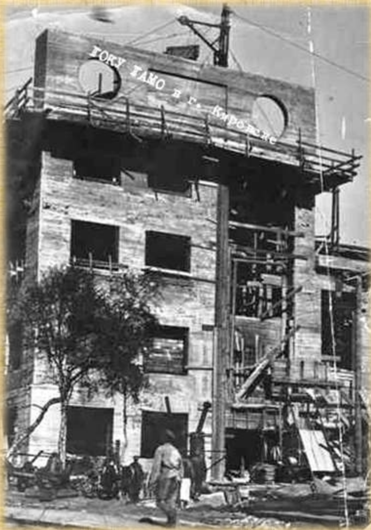
Строительство нового клуба горняков. 1932 г.
